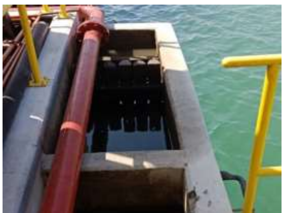
รูปที่ 3-3 บ่อ API บน JETTY คลังน้ำมันเชลล์ สงขลา
