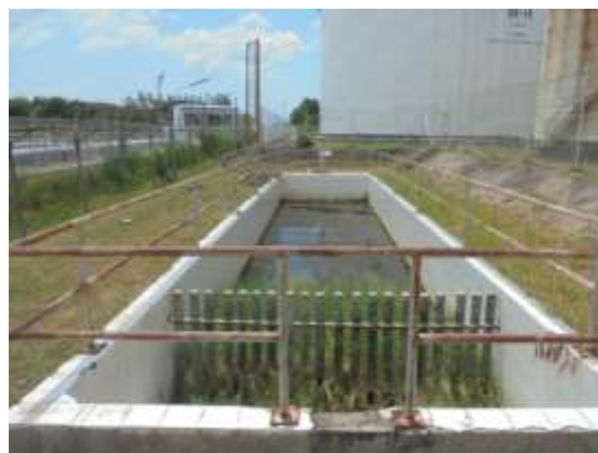
รูปที่ 3-2 บ่อ CPI หลังคลังน้ำมันเชลล์ สงขลา
